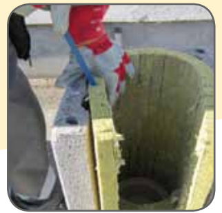
8.3- 8.4 A nyílással ellátott köpenytéglát felhelyezzük. A felesleges habarcsot lehúzzuk, a nyitott felfekvésű hézagokat teljesen eltömítjük. Meghajlítjuk és behelyezzük a szigetelő lapokat. Az elülső szellőztető csatornákat szabadon kell hagyni, ezért a hőszigetelő lapot le kell vágni.
