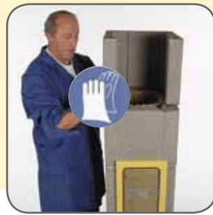
8.3- 8.4 A nyílással ellátott köpenytéglát felhelyezzük. A felesleges habarcsot lehúzzuk, a nyitott felfekvésű hézagokat teljesen eltömítjük. Meghajlítjuk és behelyezzük a szigetelő lapokat. Az elülső szellőztető csatornákat szabadon kell hagyni, ezért a hőszigetelő lapot le kell vágni.
