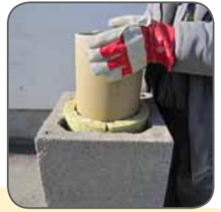
6.4 A samottcsövet behelyezzük és a kinyomódó hézagkittet letöröljük.
