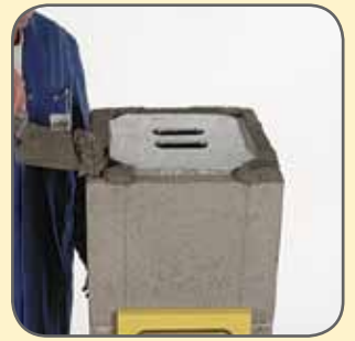
7.4 A habarcs-sablon segítségével habarcsot hordunk fel a kéménytalp tetejére. A sarokfuratokba ne kerüljön habarcs.
