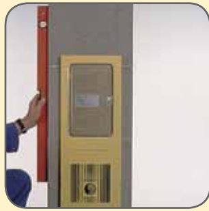
7.2 A kéménytalpat függőlegesen a habarcsba állítjuk.
