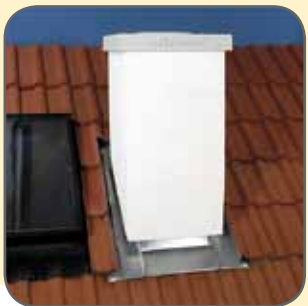
13. A kéményfejet függőlegesen felhelyezzük. Az oldalsó csavarokat a köpenytégláig meghúzzuk. A torkolati kúpot felhelyezzük (ld.: 11.1-11.11 ábrák)
