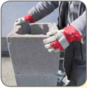
6.1 A köpenytéglát a habarcs-terítésbe helyezzük
