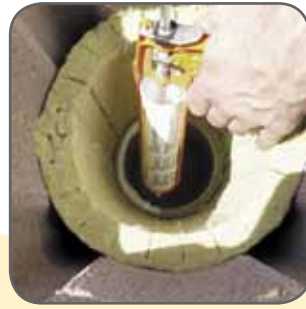
6.3 A samottcső felső, külső korcolású felületére hézagkittet nyomunk. A következő samottcső mindkét végét megnedvesítjük.
