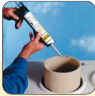
11.10 Helyezzük be a samottcső darabot, a sima vágott csővég áll felfelé. Kenjük be a végét hézagkittel.
