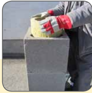
6.2 A szigetelő lapot meghajlítjuk és behelyezzük.
