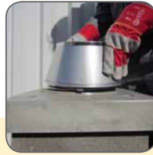
11.11 A torkolati kúpot húzzuk rá a samottcsőre és a belső vállaival ültessük fel a gyűrű peremére.
